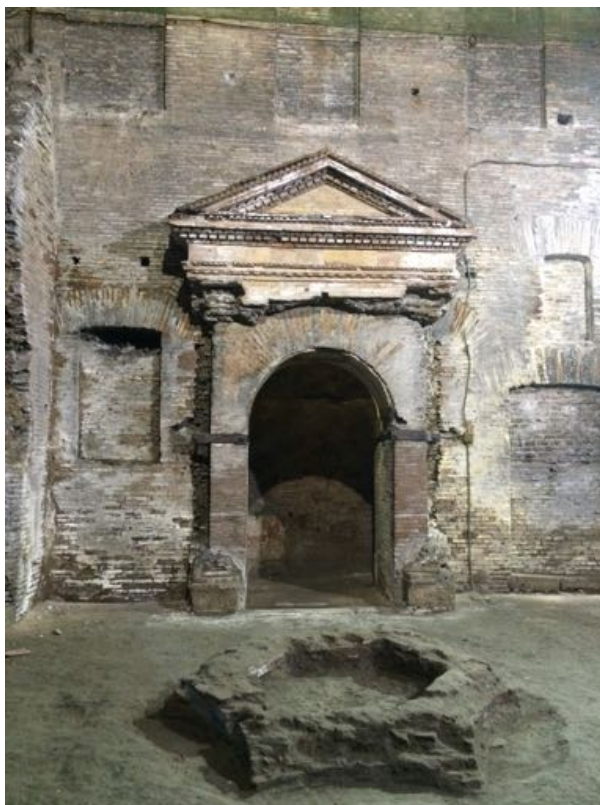
Fig. 3 Cortile H visto da nord. In primo piano la fontana esagonale, sul fondo l'edicola I . Si notino in alto sopra l'edicola le tre finestre ora tamponate del primo piano
