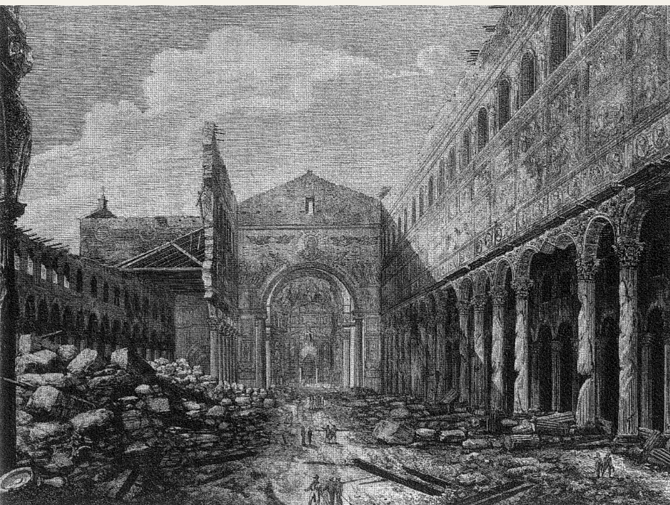
Fig. 2 - L'interno della basilica in rovina vista dall'ingresso, 1823. Incisione di Luigi Rossini eseguita a seguito del disastro. Il fuoco della Basilica di San Paolo fuori le mura nel 1823. Di Luigi Rossini- Luigi Rossini, Public Domain, https://commons.wikimedia.org/w/index.php?curid=9826506
